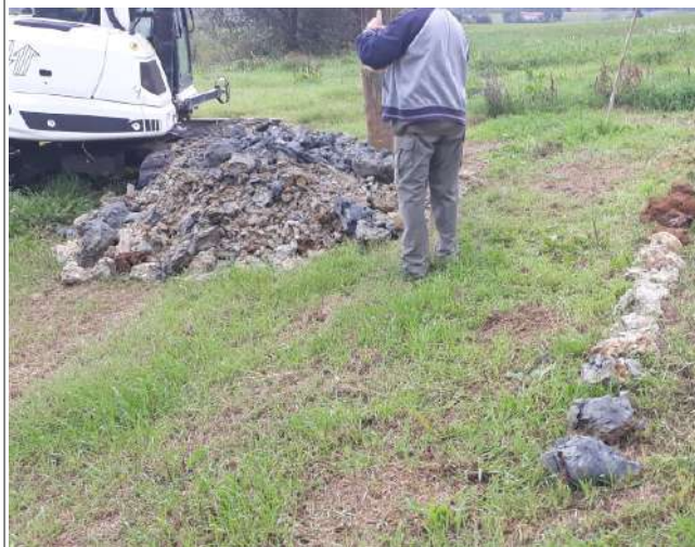
Foto1. Esecuzione sondaggio S2
