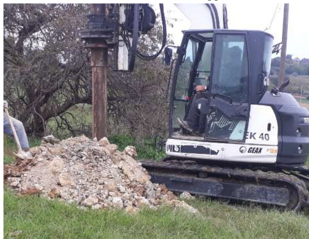
Foto1. Esecuzione sondaggio S1
