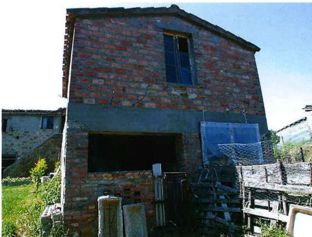
Fig. 6D – Vista edificio posteriore
