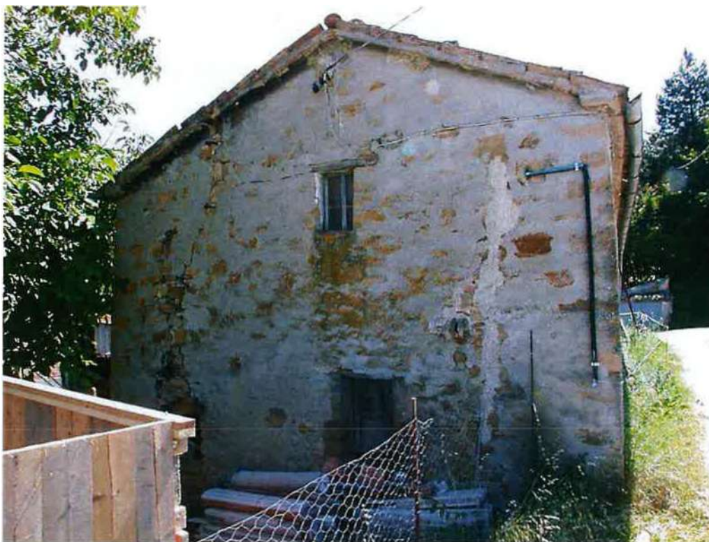
Fig. 6A - Vista lato strada
