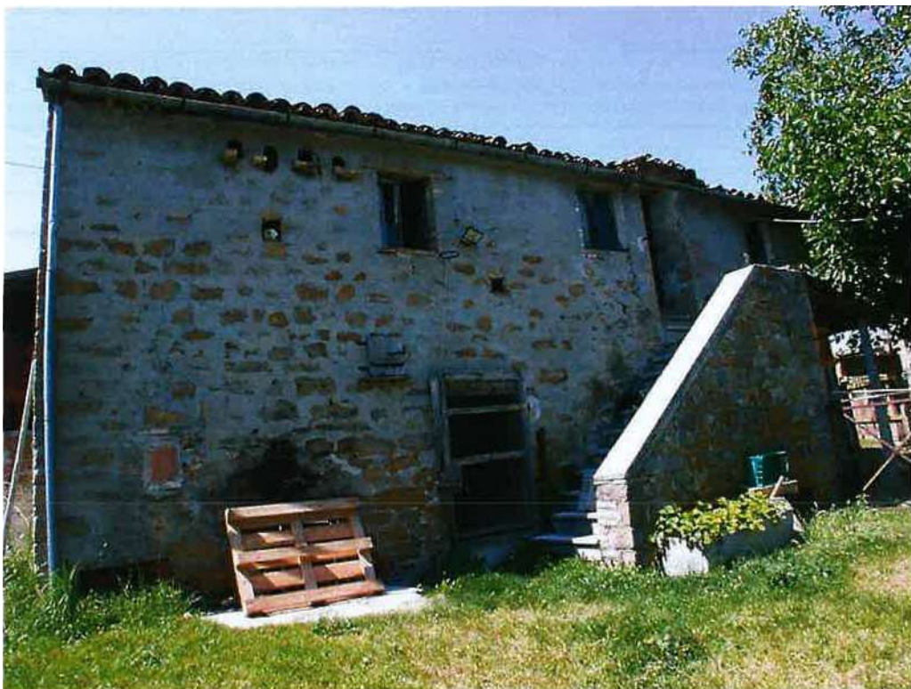
Fig. 6C - Vista posteriore lato strada
